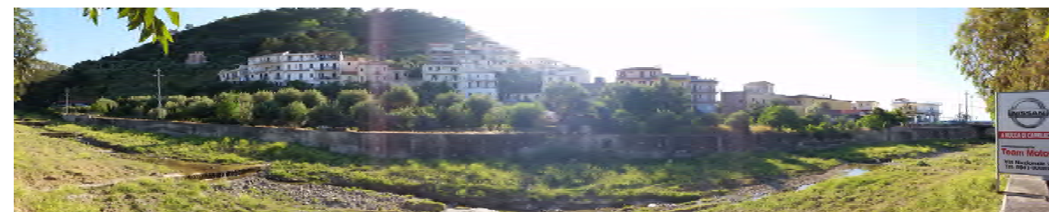
A - Panoramica da est del profilo del muro d'argine
