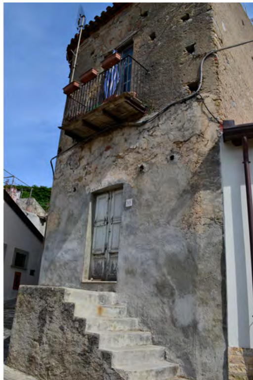
Foto fronte principale
