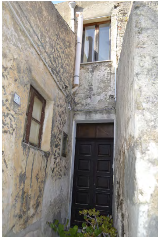
Foto fronte principale
