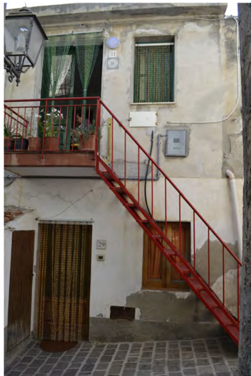
Foto fronte principale
