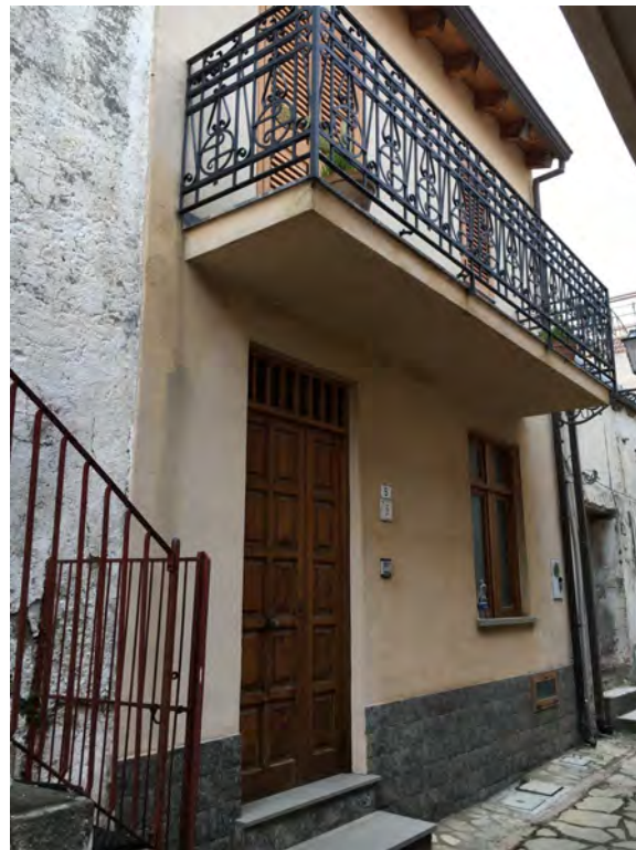
Foto fronte principale
