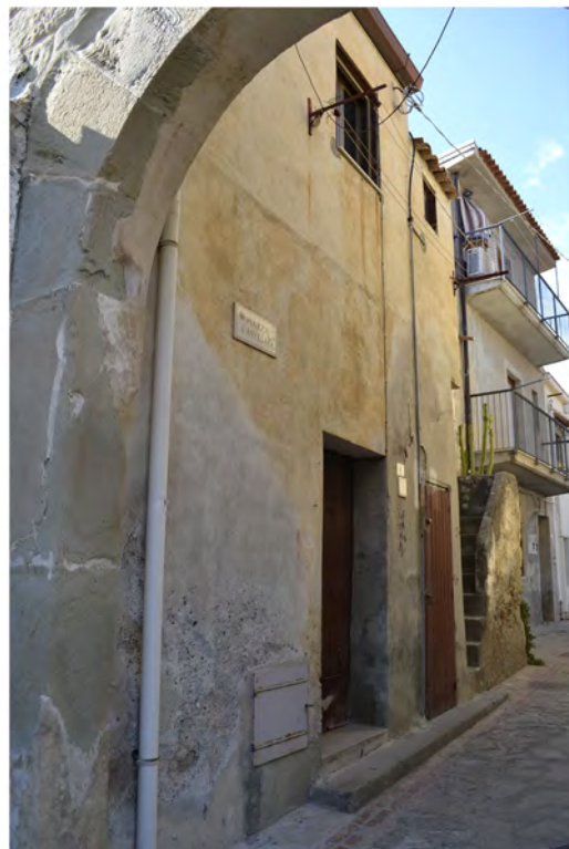
Foto fronte principale
