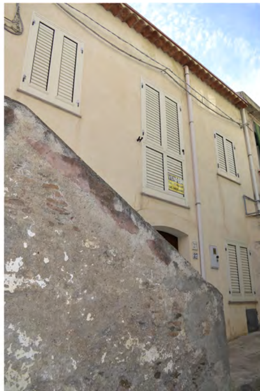
Foto fronte principale
