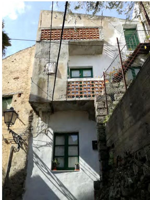
Foto fronte principale
