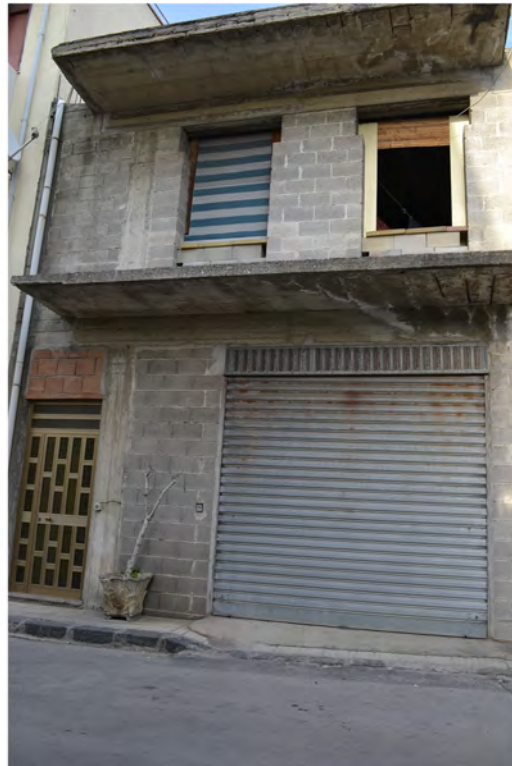
Foto fronte principale
