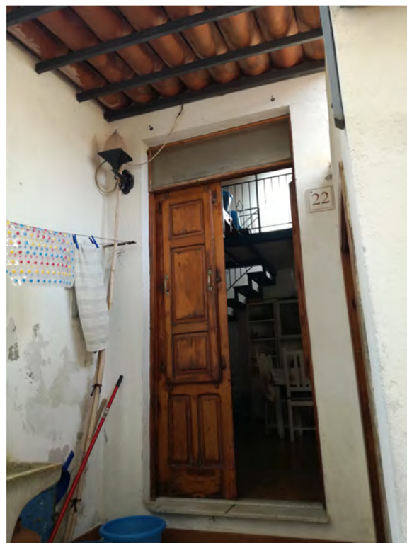
Foto fronte principale
