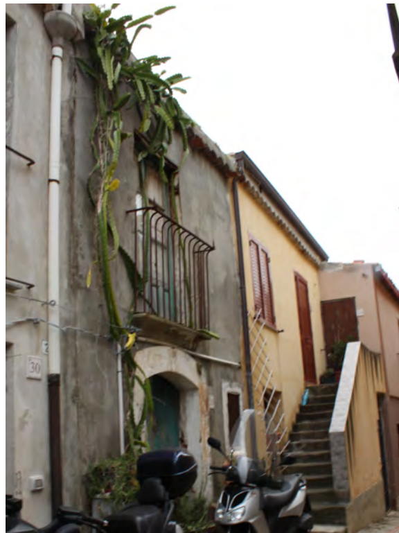
Foto fronte principale
