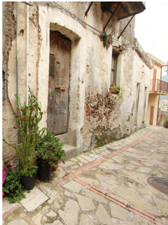
Foto fronte principale
