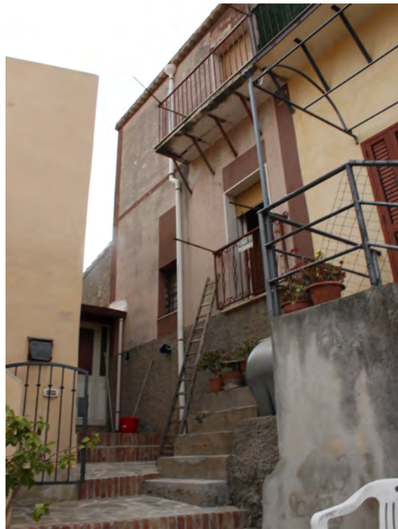
Foto fronte principale
