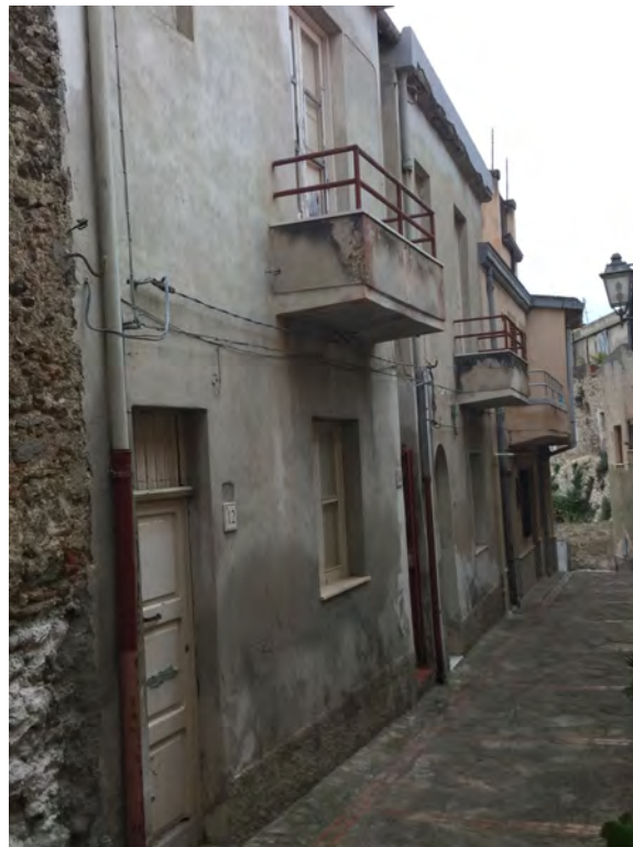
Foto fronte principale
