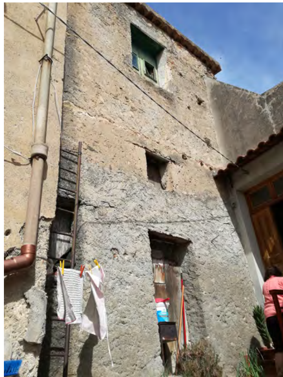
Foto fronte principale
