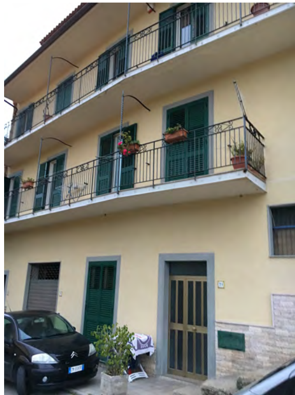
Foto fronte principale
