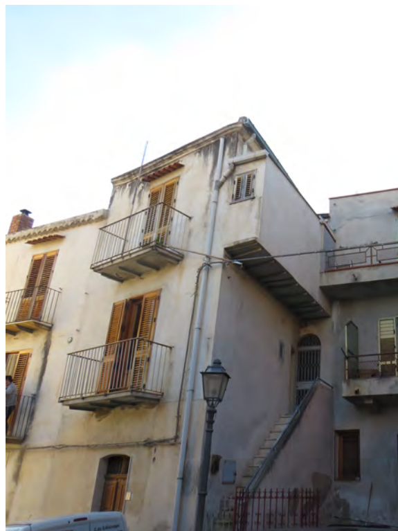
Foto fronte principale
