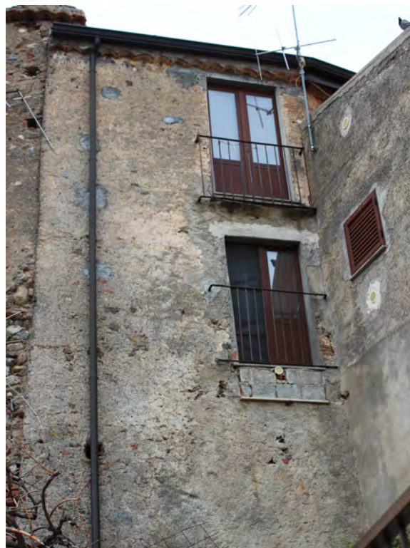
Foto fronte principale
