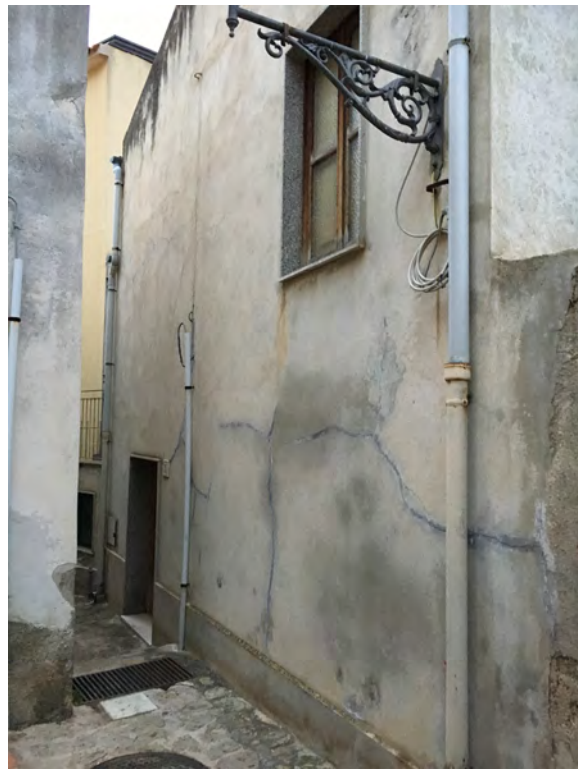
Foto fronte principale
