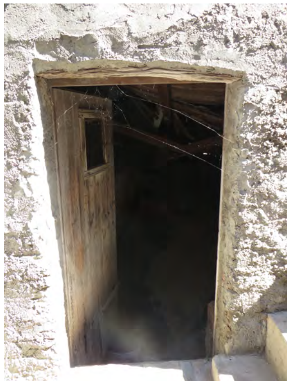
Foto fronte principale
