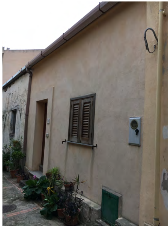
Foto fronte principale
