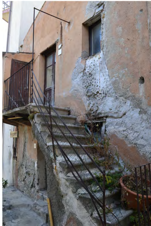
Foto fronte principale
