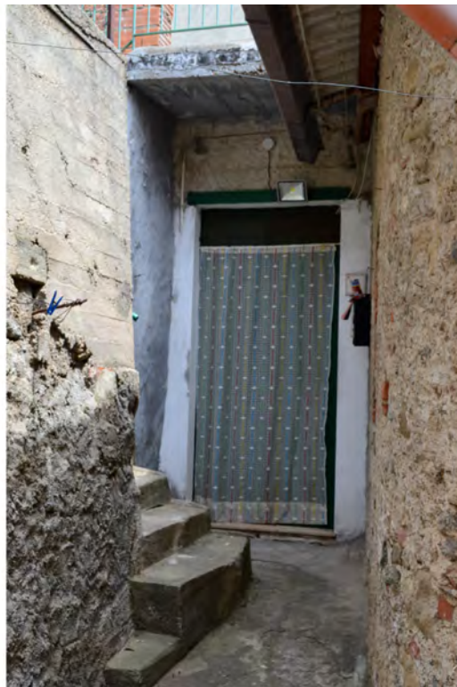
Foto fronte principale
