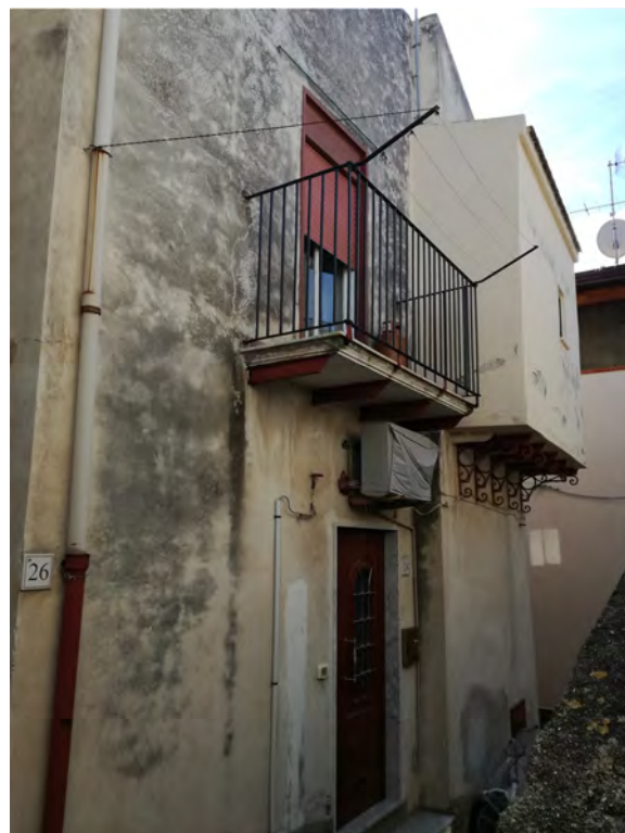
Foto fronte principale
