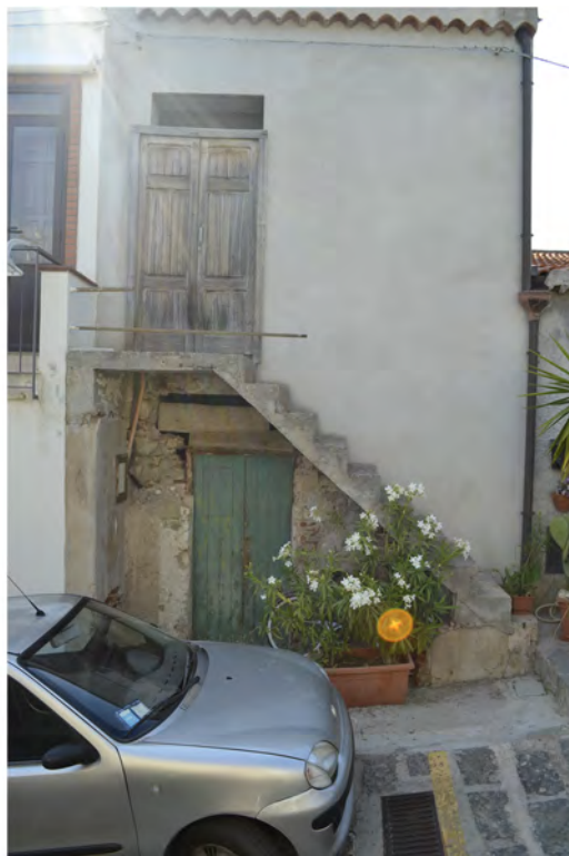
Foto fronte principale
