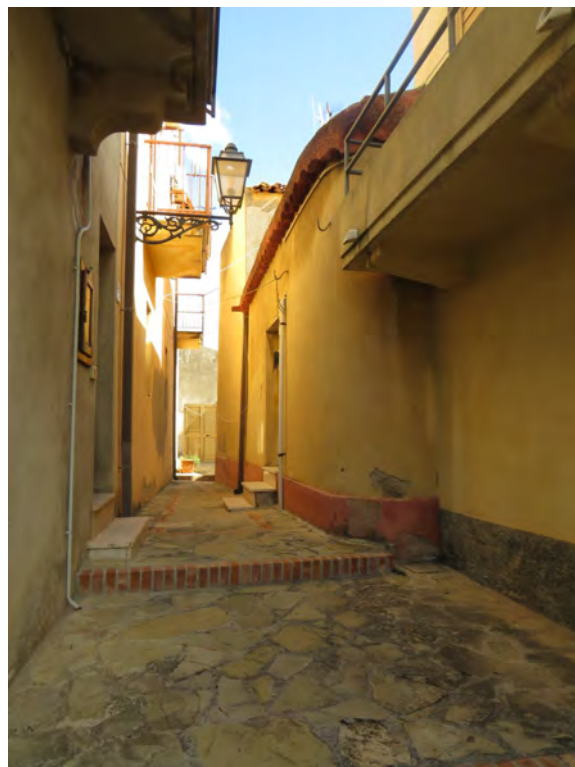
Foto fronte principale
