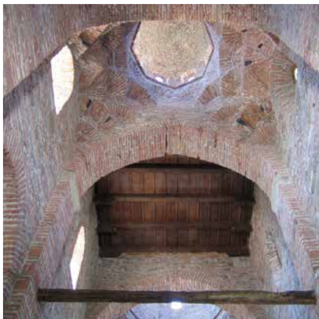
Fig.14 - Brolo, particolare della volta costolonata
