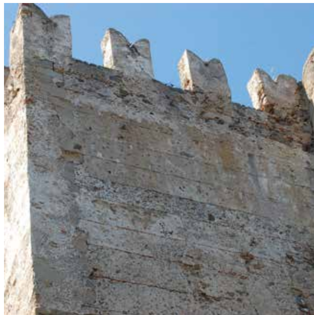
Fig.18 - Particolare della tecnica costruttiva a bancate con ricorsi in mattoni. Dall'immagine è chiaramente visibile la funzione strutturale, e non decorativa, degli elementi in cotto
