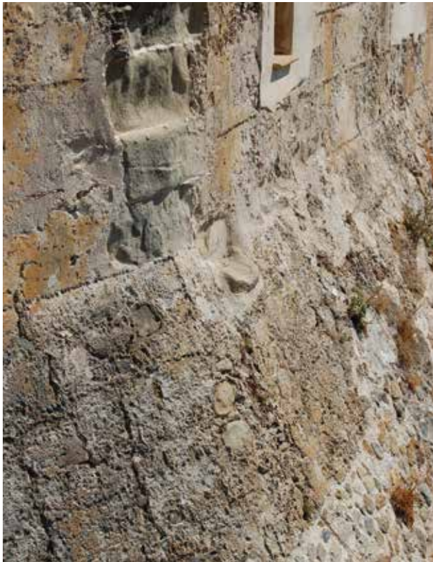
Fig.8 - La canaletta in pietra arenaria presente fra la muratura verticale e l'inizio della scarpa della seconda cinta muraria
