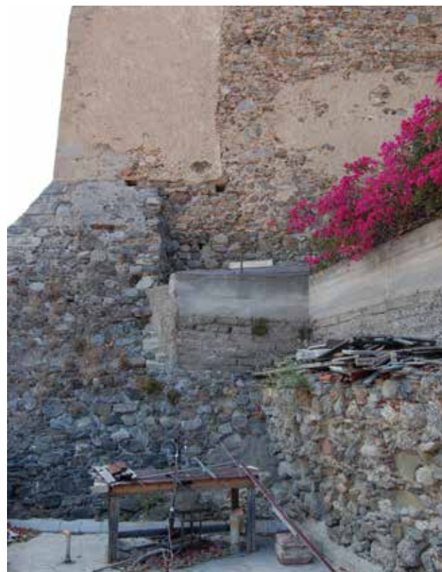
Fig.14 - La muratura perpendicolare al prospetto est della torre ad oggi conservata all'interno di un cortile di un'abitazione
