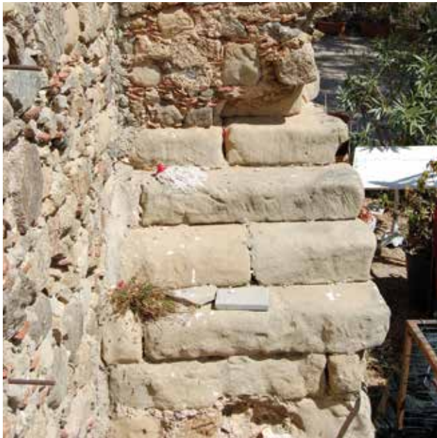
Fig.16 - La scala originaria di accesso alla torre e la sua risistemazione in epoca moderna
