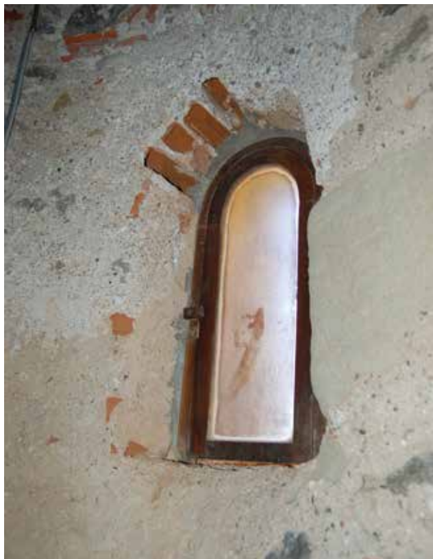
Fig.22 - Una delle aperture presenti nella torre scalare dove risulta ben evidente la ricostruzione della monofora operata con il laterizio sulla prima fase costruttiva in pietra arenaria
