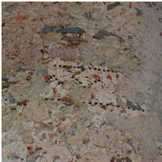
Fig.13 - Particolare dell'intonaco beige presente sulla parete est della torre dove viene ben evidenziata la leggera inclinazione verso l'esterno, segno dell'attacco di una muratura perpendicolare alla parete in oggetto
