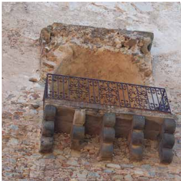
Fig.19 - L'apertura con balcone presente nel prospetto est della torre
