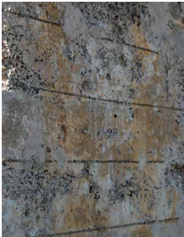
Fig.3 - Particolare dell'intonaco bianco con pillole di pietra di fiume presente sulla seconda cinta
