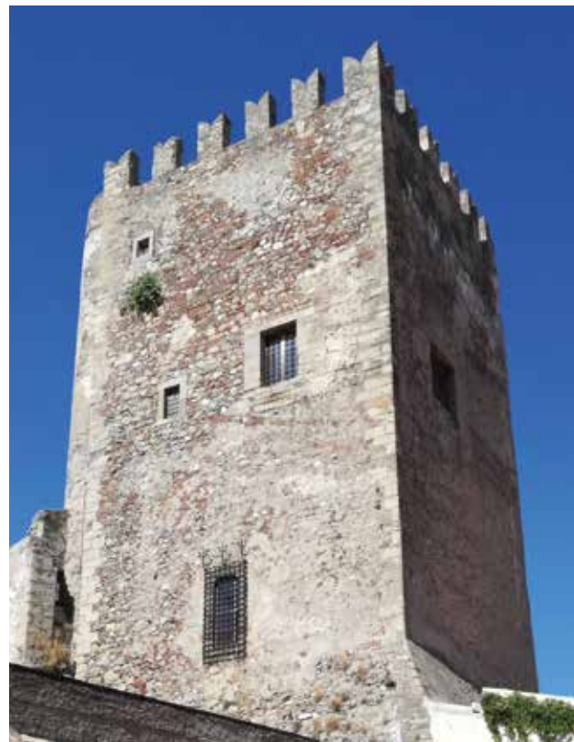
Fig.6 - Fronte ovest della torre oggi. Si notino le integrazioni in mattoni e la nuova finestra
