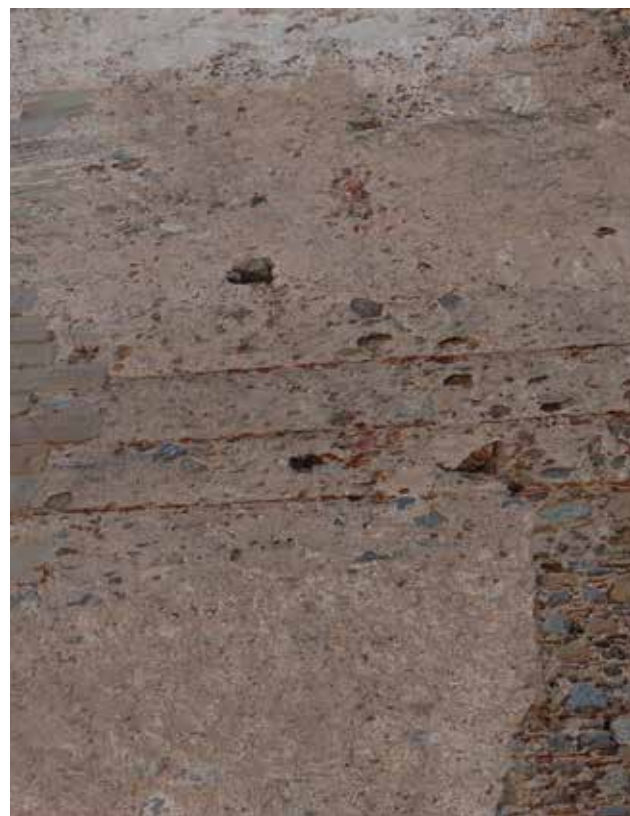
Fig.2 - Brolo, particolare di una porzione di paramento murario con cantonale e tessitura muraria della torre
