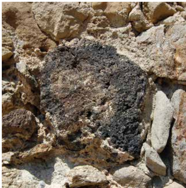
Fig.13 - Particolare dell'intonaco beige presente sulla parete est della torre dove viene ben evidenziata la leggera inclinazione verso l'esterno, segno dell'attacco di una muratura perpendicolare alla parete in oggetto
